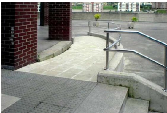
Gráfico 3. Solución integrada para permitir el acceso y la salida del edificio a todos los usuarios. Acceso a la cafetería de la Facultad de Ingeniería Industrial y de Telecomunicaciones, Universidad de Cantabria. Solución integrada para permitir el acceso y la salida del edificio a todos los usuarios. Fuente: Fundación ONCE. Accesibilidad Universal y Diseño para Todos. Arquitectura y Urbanismo ;2011.
